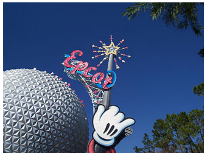
Pannellatura della superficie bugnata della sfera geodetica della astronave Earth a Epcot, Walt Disney World Resort (in AlucoBond )
